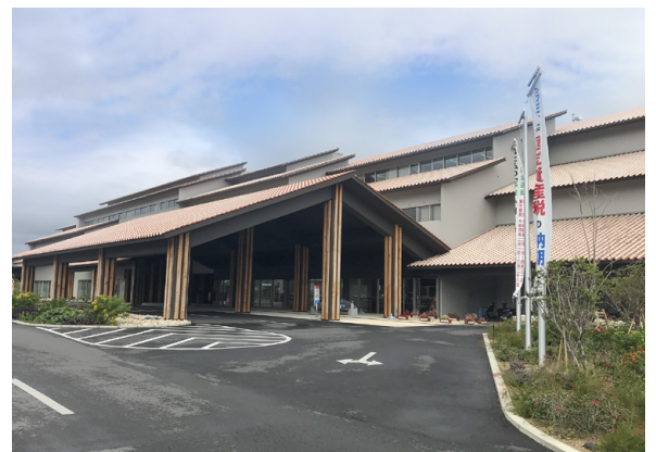
▲2021年11月に完成した石垣市の新庁舎
